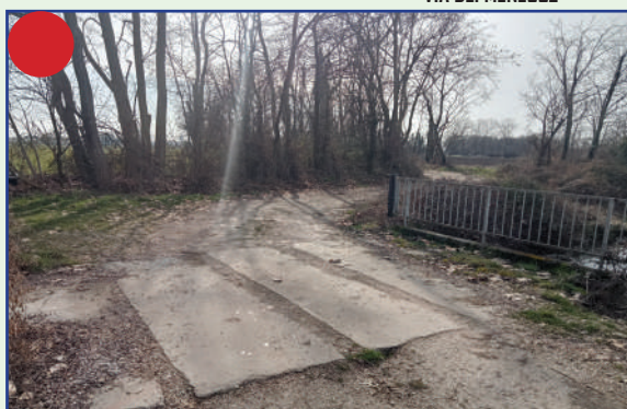
CHICANE SU PONTE
