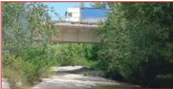
SOTTO PONTE CASARSA SS1+SS2+SS3
