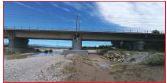
SOTTO PONTE FERROVIA SS1+SS2+SS3
